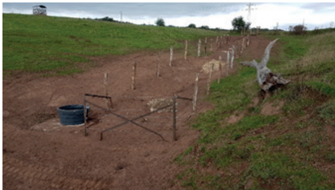
Direkt nach Beendigung der Baustelle
