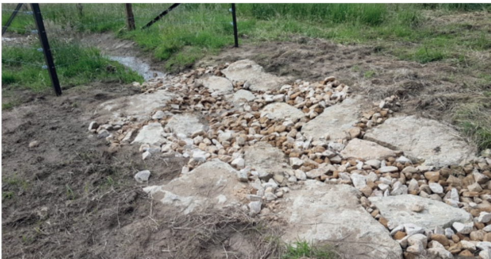
61B: 2 mit mit Steinen ausgelegte Durchfahrten ersetzen die Rohre und sind für die im Wasser lebenden Kleintiere gut passierbar
