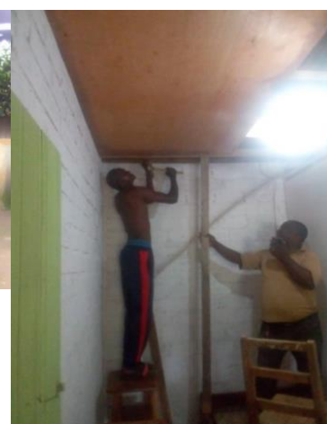
Début des travaux
