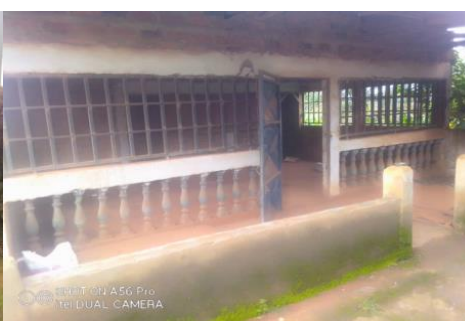
Espace avant travaux
