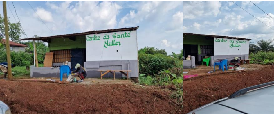
Finalisation des travaux extérieurs
